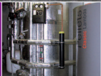
Thermohydraulische Schichtweichen können im Basismodul bis 1000 Liter mit bis zu 4,6 m³/h beladen werden, ohne dass die Schichtung im Speicher zerstört wird.
