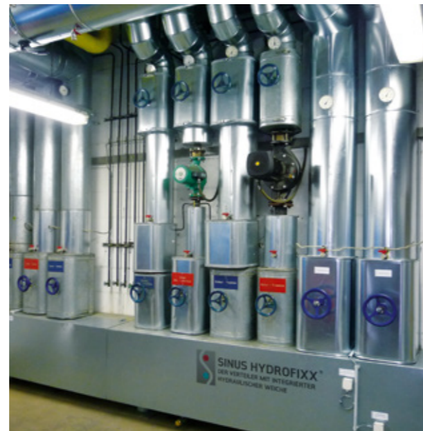
Sinus HydroFixx in Großbauweise für Anlagen bis 4,5 MW
