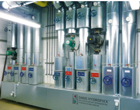
Sinus HydroFixx in Großbauweise für Anlagen bis 2,1 MW
