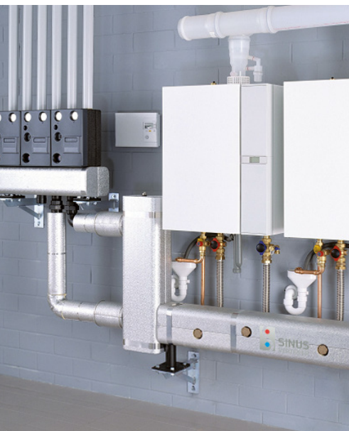
Moderne Heizungsanlage mit integrierter Hydraulischer Weiche (Sinus Kaskaden Unit)
